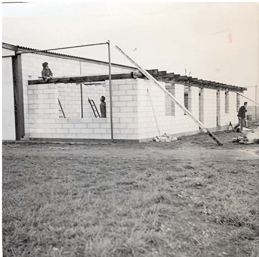
Hangaren er færdig. Nu bygges klubhuset 1970
